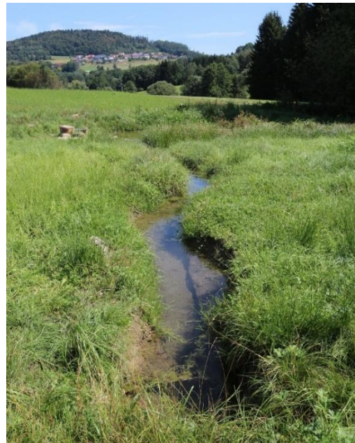
Abb. 1: Ein offener, neu angelegter Graben beginnt ab dem gekappten Drainagerohr am unteren Ende der Wirtschaftswiese und endet in einem Tümpel.
