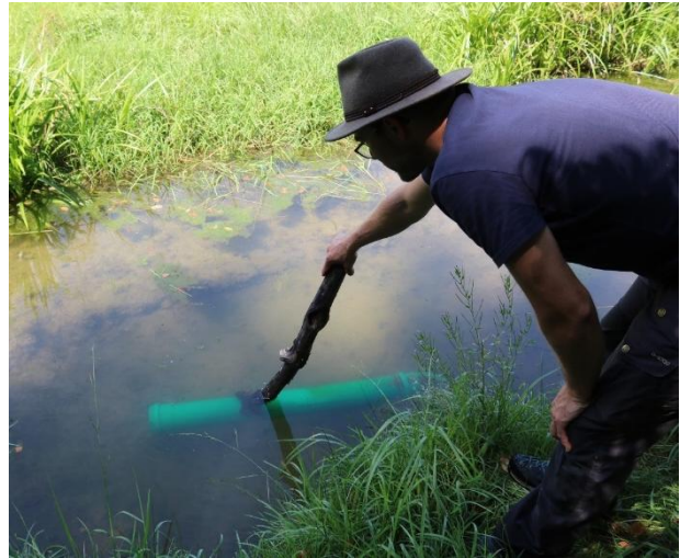
Abb. 3: Ein KG-Rohr, das normalerweise aus dem Wasser herausragt (oben links), kann zur Wasserstandsenkung unter Wasser gedrückt werden (oben rechts). Das Rohr ist in der Verwallung verbaut und mündet in den Fichtenwald (nach links im oberen linken Bild).
