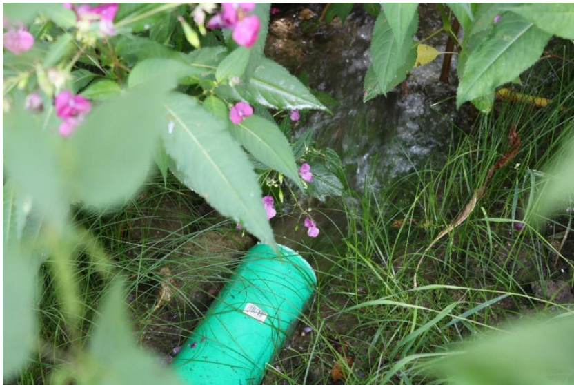
Abb. 3: Ein KG-Rohr, das normalerweise aus dem Wasser herausragt (oben links), kann zur Wasserstandsenkung unter Wasser gedrückt werden (oben rechts). Das Rohr ist in der Verwallung verbaut und mündet in den Fichtenwald (nach links im oberen linken Bild).
