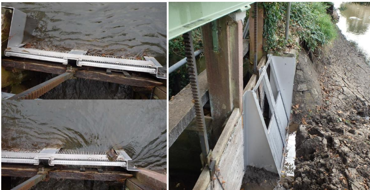
Abb. 6: Der Fischrechen wird an ein bestehendes Wehr montiert (rechts) und muss regelmäßig gereinigt werden, damit Wasser in die Gräben fließen kann (links - oben verstopft, unten gereinigt). Fotos: Referat 56, RP Freiburg
