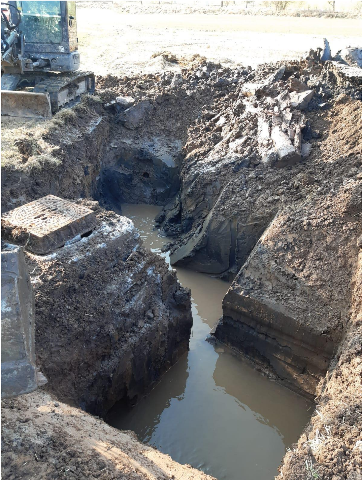
Abb. 8: Trennen und Verplomben des Drainagesammlers. Foto: Sebastian Rall
