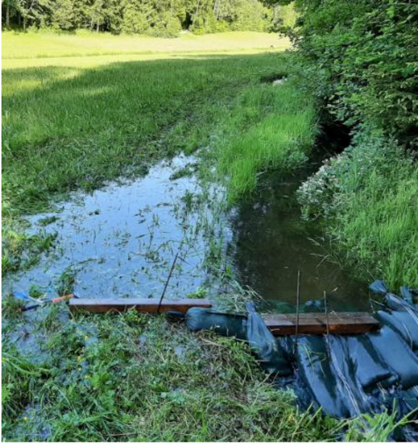
Abb. 1: Die Sandsäcke im Mühlkanal stauen das Wasser an. Dadurch wird die darunter liegende Wiese überflutet und kurzweilig geflutet. Fotos: Wolfgang Degelmann
