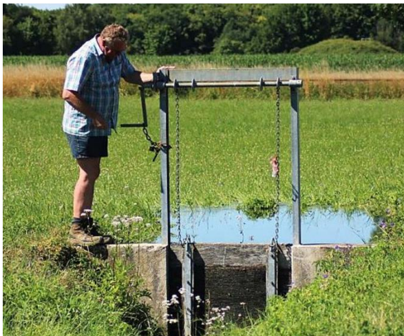
Abb. 2: Links: Der „Erste Bauherr“ und Wässerer der Wassergenossenschaft bedient einen Kurbelschütz in der „Gosberger Zweng“. Foto: Landratsamt Forchheim. Rechts: Das „Gosberger Wehr“ ist eines von zwei Großwehren in den Forchheimer Wässerswiesen.
