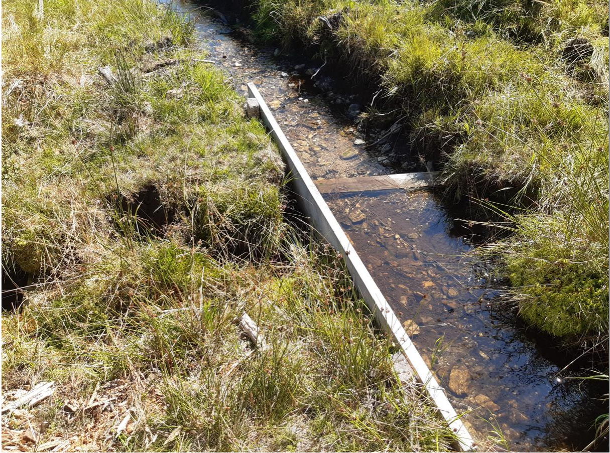
Abb. 8: Eine Staukonstruktion, die Gewässerdurchgängigkeit gewährleistet und verhindert, dass die maximale Wasserentnahmemenge überschritten wird. Die Sohlschwelle links befindet sich am Eingang des Grabensystems. Das Holzbrett im Bach lässt einen Spalt zwischen der Brettunterkante und Gewässersohle.
