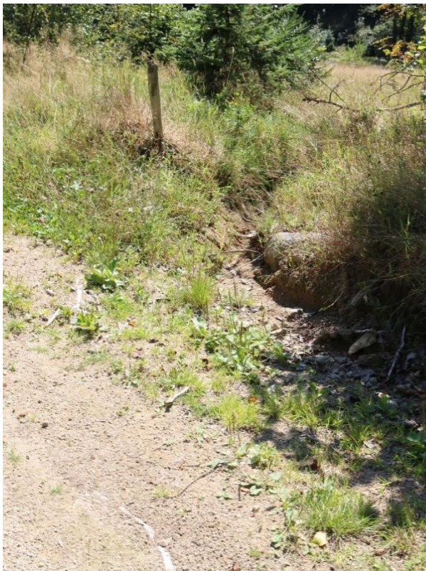
Abb. 4: Links unten: Der Wegseitengraben wird hangabwärts durch eine Auskehrung (rechts im Bild) verlängert und berieselt dadurch die darunter liegende Fläche. Oben: Das Rohr läuft von der hangaufwärts liegenden Seite unter dem Weg hindurch und leitet das eigentlich zur Entwässerung gedachte Wasser in einen kleinen Tümpel um. Eingang und Ausgang des Rohres sind mit roten Pfeilen versehen. Rechts unten: Wasser aus dem Entwässerungsgraben fließt in ein Rohr, das sich unter dem Weg durchzieht. Fotos: Thomas Köhler
