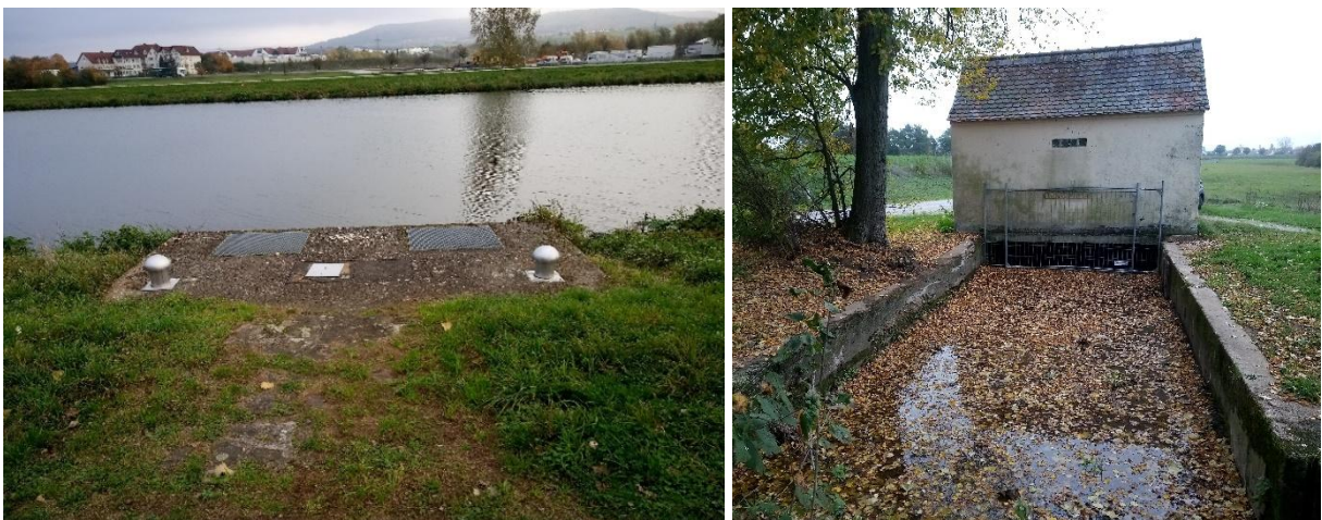
Abb. 3: Die Entnahmestelle am Main-Donau-Kanal (links) leitet das Wasser über zwei Rohre in das Häuschen (rechts). Von dort aus gelangt das Wasser in die Betongräben. Foto: Anton Hofmann
