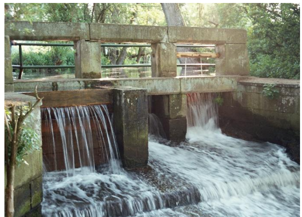
Abb. 3: In der Queich und in den Grabenstrukturen kommen verschiedene Querbauwerke zum Einsatz, wie zum Beispiel einfache Stauschieber (links oben), Kurbelwehre (rechts oben und links unten) und sogar ein großes Teilungswehr mit Steckbrettern (rechts unten – links im Bild sind die eingesteckten Bretter zu erkennen). Beim Teilungswehr wurde eine Fischtrappe gebaut, um die Längsdurchgängigkeit zu gewährleisten. Fotos: Peter Keller, Pirmin Hilsendegen
