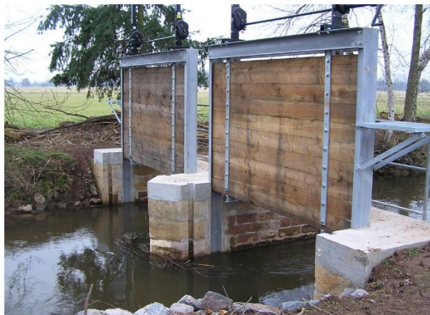
Abb. 3: In der Queich und in den Grabenstrukturen kommen verschiedene Querbauwerke zum Einsatz, wie zum Beispiel einfache Stauschieber (links oben), Kurbelwehre (rechts oben und links unten) und sogar ein großes Teilungswehr mit Steckbrettern (rechts unten – links im Bild sind die eingesteckten Bretter zu erkennen). Beim Teilungswehr wurde eine Fischtrappe gebaut, um die Längsdurchgängigkeit zu gewährleisten. Fotos: Peter Keller, Pirmin Hilsendegen
