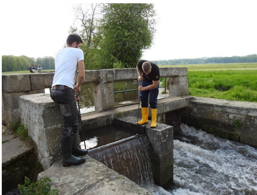
Abb. 4: Die einzelnen Staubretter werden in die Ritzen links und rechts in den Betonsäulen des Teilungswehrs gesteckt. Das erfordert viel Kraft. Foto: Pirmin Hilsendegen
