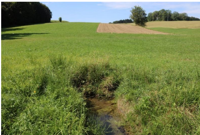
Abb. 1: Ein offener, neu angelegter Graben beginnt ab dem gekappten Drainagerohr am unteren Ende der Wirtschaftswiese und endet in einem Tümpel.
