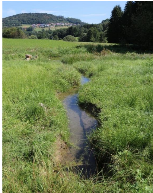
Abb. 1: Ein offener, neu angelegter Graben beginnt ab dem gekappten Drainagerohr am unteren Ende der Wirtschaftswiese und endet in einem Tümpel.
