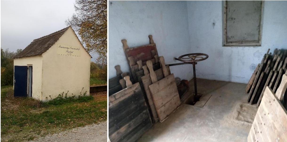
**Abb. 2:** In dem kleinen Häuschen (links) befinden sich die beiden Schieber zum Öffnen und Schließen der Einlassrohre. Die Bedienung der Schieber erfolgt durch Drehen der Handkurbel. Foto: Anton Hofmann
