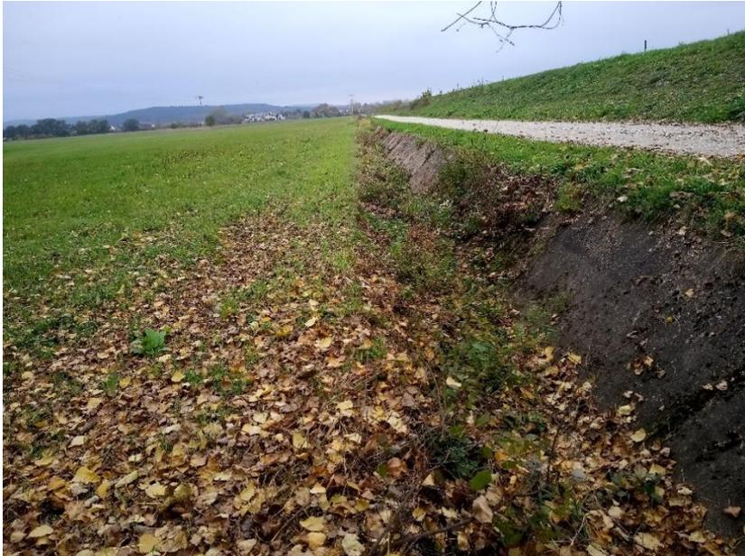
**Abb. 4:** Im Bewässerungsgraben (rechts im Bild) hat sich inzwischen viel Sediment abgelagert, weshalb der Betonuntergrund gar nicht mehr zu sehen ist. Rechts vom Graben befindet sich der Kanal. Bei Einstau bewässert der Graben die Wiese links im Bild. Foto: Anton Hofmann
