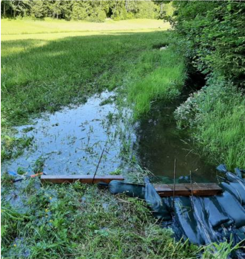
Abb. 1: Die Sandsäcke im Mühlkanal stauen das Wasser an. Dadurch wird die darunter liegende Wiese überrieselt und kurzweilig geflutet. Fotos: Wolfgang Degelmann
