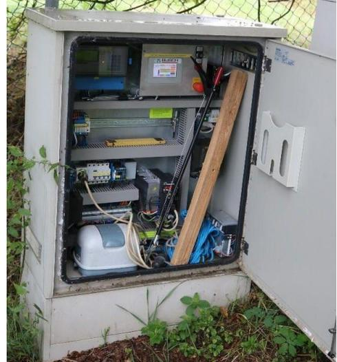
**Abb. 4:** Ein Sensor misst die Durchflussmenge des Wassers (links). Diese wird dann mit der Soll-Durchflussmenge verglichen. Gelangt zum Beispiel mehr Wasser ins Grabensystem als es soll, verringert das System im Schaltkasten (rechts) in Verbindung mit dem Motorschieber im Betonschacht automatisch den Durchfluss. Fotos: Thomas Köhler
