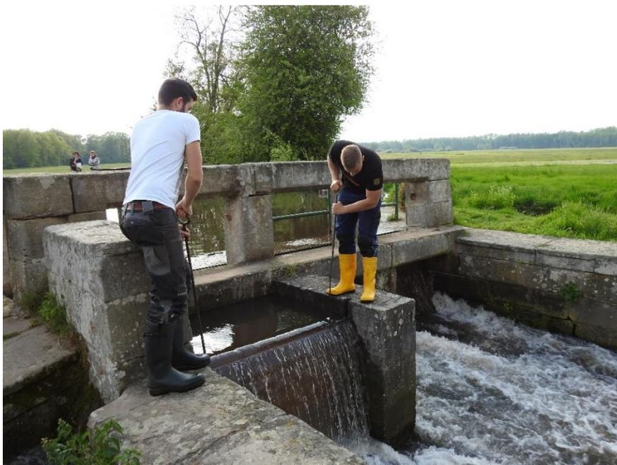
**Abb. 4:** Die einzelnen Staubretter werden in die Ritzen links und rechts in den Betonsäulen des Teilungwehrs gesteckt. Das erfordert viel Kraft. Foto: Pirmin Hilsendegen
