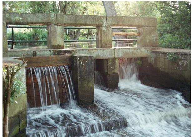
**Abb. 3:** In der Queich und in den Grabenstrukturen kommen verschiedene Querbauwerke zum Einsatz, wie zum Beispiel einfache Stauschieber (links oben), Kurbelwehre (rechts oben und links unten) und sogar ein großes Teilungwehr mit Steckbrettern (rechts unten – links im Bild sind die eingesteckten Bretter zu erkennen). Beim Teilungwehr wurde eine Fischtrappe gebaut, um die Längsdurchgängigkeit zu gewährleisten. Fotos: Peter Keller, Pirmin Hilsendegen
