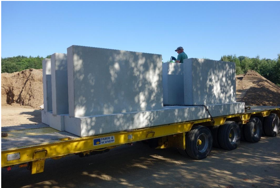
Abb. 3: Transport der Betonkörper.
